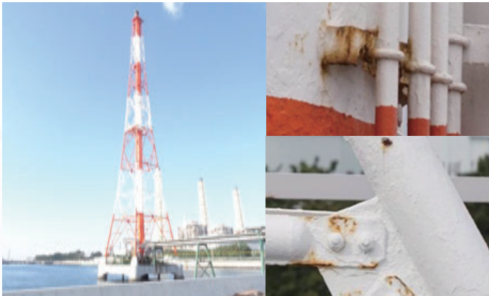
フレアスタック
