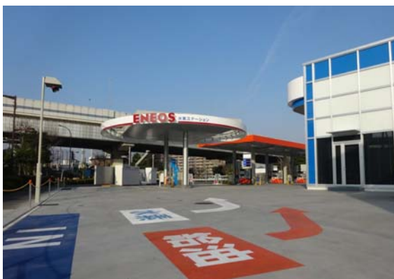
【Dr. Driveセルフ潮見公園店水素ステーションの外観】
